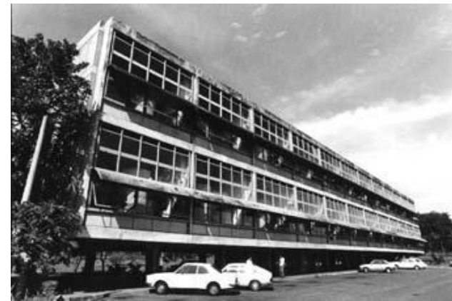
Figura 33- Fachada Principal UnB
