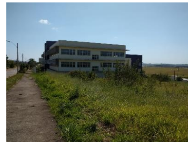
Figura 23- Unifal - Bloco B
