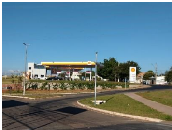
Figura 45- Posto gasolina 200m
